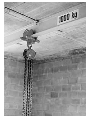
Figure 4: inscription bien lisible de la charge maximale de la voie de roulement.
