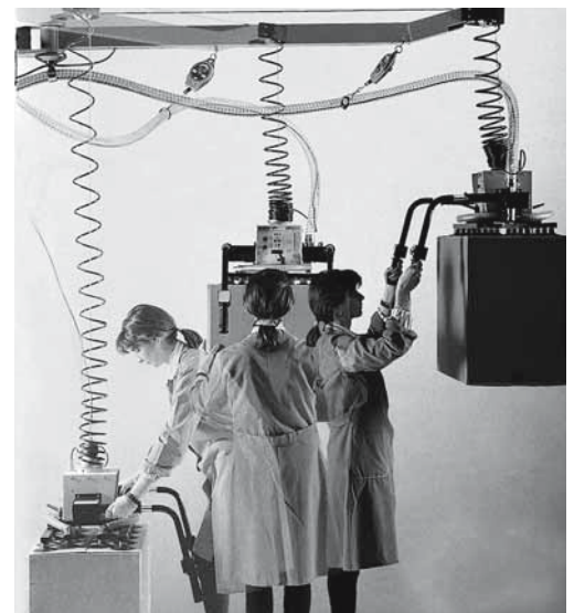
Des équilibreurs de charges permettent de manipuler des marchandises lourdes sans efforts inconsiderés.
