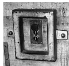
Fig. 4: la commande, encastrée dans le mur ou entourée d'un cadre robuste, est protégée des chocs dus aux véhicules.
