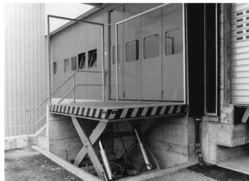
Fig. 1: lorsque la plate-forme est abaissée, le garde-corps forme une barrière de 1 m au niveau du quai supérieur.
